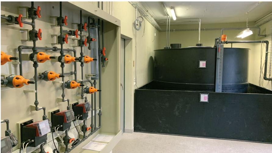
Gesamte Tankanlage eines 14 m<sup>3</sup> Tanks mit Dosiertableau und Auffangwanne
